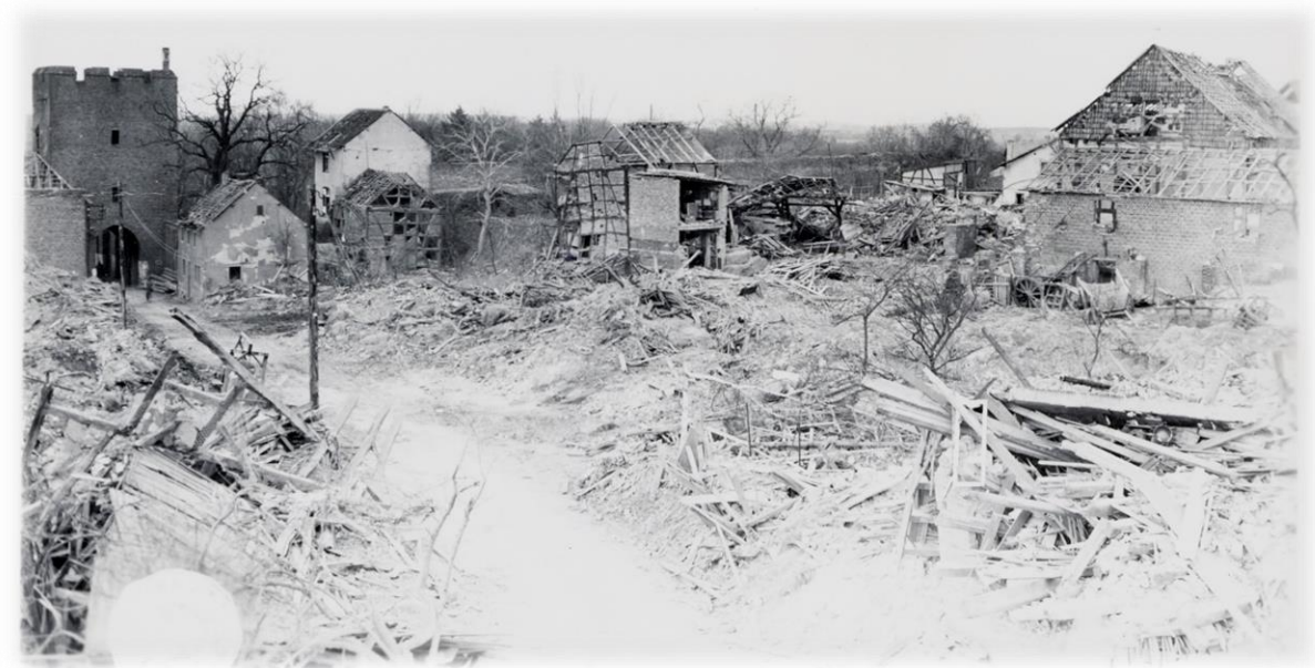
Unten: Zerstörungen am Bachtor (stadtwärtige Seite).
