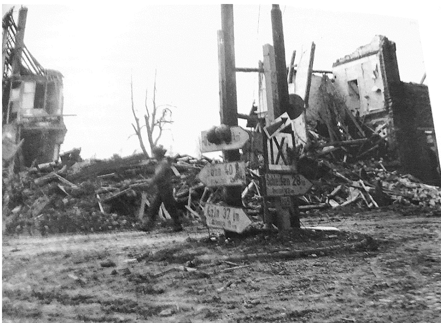
Zerstörte Gebäude in Zülrich. Schwer zu erkennen die Wegweiser nach Düsseldorf, Bonn, Euskirchen, Köln, Lechenich, Schleiden und Gemünd.
