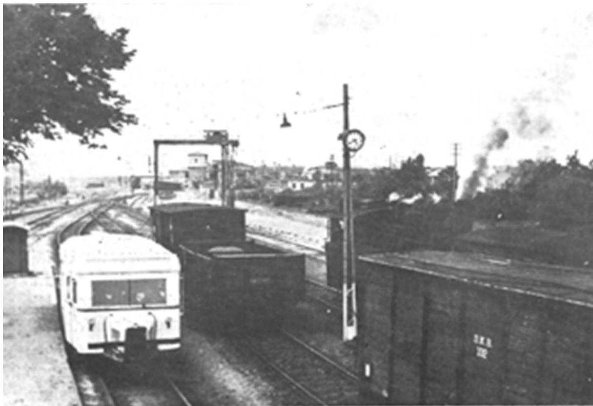
Der neue Schienenbus hatte 32 Sitzplätze und 14 Stehplätze. Seine Geschwindigkeit betrug 40 km/h. Für die Strecke Distelrath - Embken brauchte er 1 h 20 min. Diese Strecke wurde vorher mit einer Dampflokomotive im 2 Stunden und 30 Minuten bewältigt
