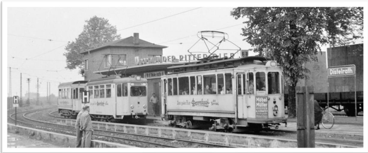
Triebwagen in dem neuen Personenbahnhof in Distelrath.
