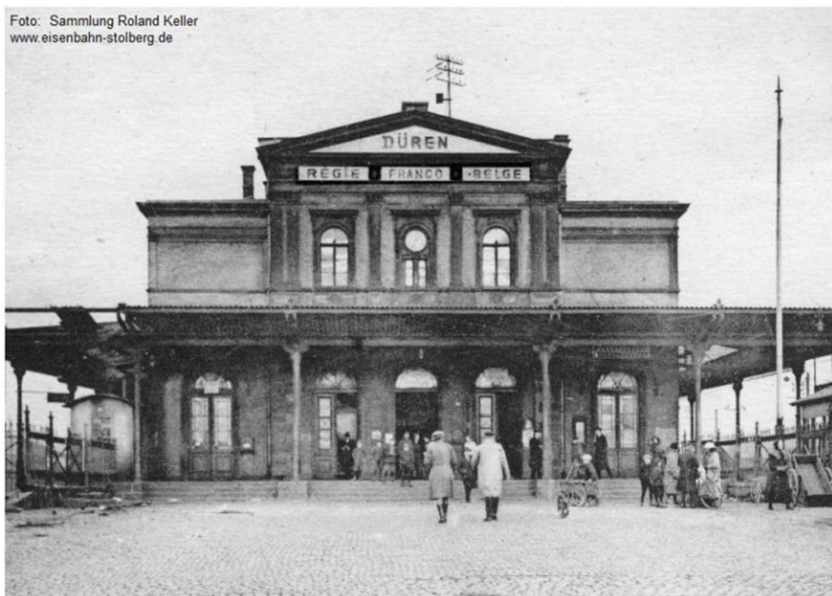
„Regie Franco Belge“ wurde 1923 am Dach des Empfangsgebäudes angebracht.
