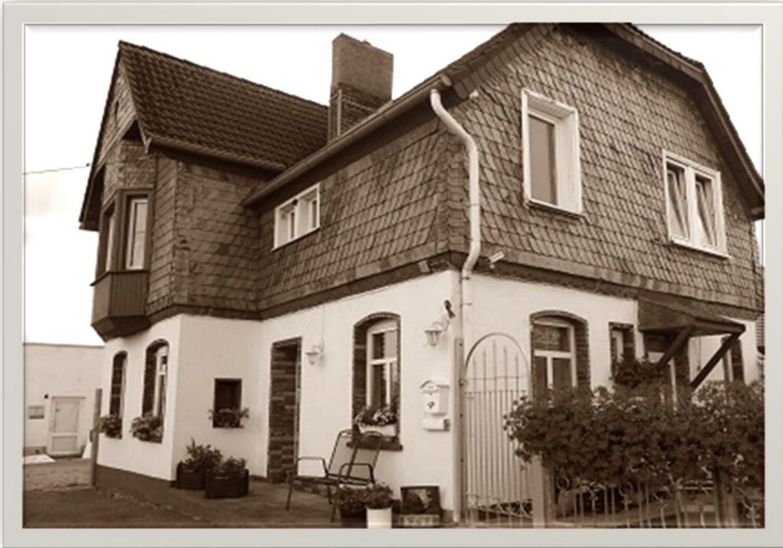
Heute noch erhalten: Übergabebahnhof der DKB ,1908 an der Römerallee .
