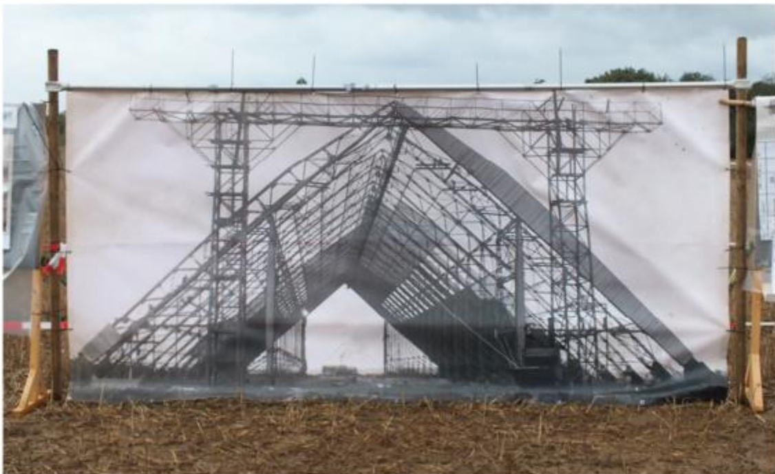
Oben: Luftschiffhalle im Bau, LVR-Präsentation
