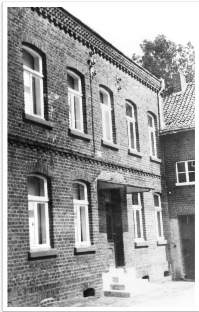
Wohnhaus an der oberen Mühle, Nörvenich.
