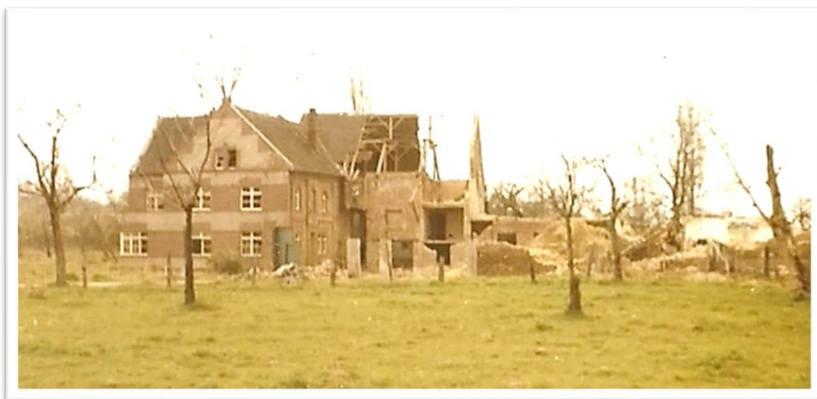
Die Biesenmühle in Füssenich wurde für den Braunkohletagebau abgerissen.
