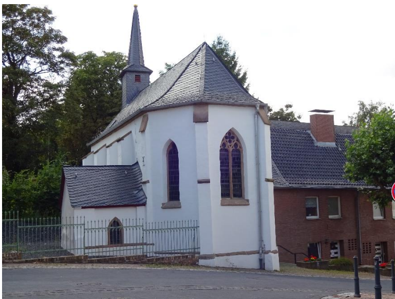
Filialkirche Gasthauskapelle, erbaut 1454.
