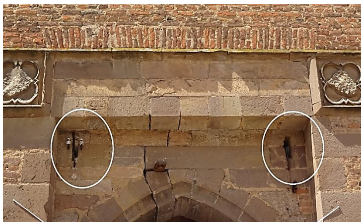
Oben: Portal mit den Rollen für die Eisenketten, rechts: Fluchttor.
