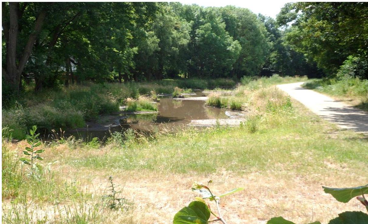
Der Neffelbach wird seit einigen Monaten im Bereich der Innerortslage in seinem bisherigen Verlauf wesentlich umgestaltet. Das bis dato gerade laufende Flussbett sorgte für eine hohe Fließgeschwindigkeit, die sehr steile und tiefe Böschungen entstehen ließ. Durch das so genannte "Schleifenlegen" des bisherigen Bachverlaufs sollen diese Gefahrenquellen für Mensch und Tier künftig beseitigt werden.
