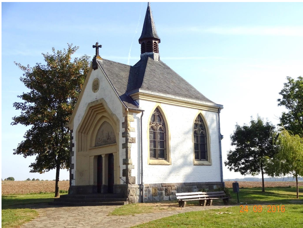
Die 1920 erbaute Kapelle im Norden von Füssenich. Die mittelalterliche Quelle befindet sich rechts unten an der Ostseite der Kapelle.
