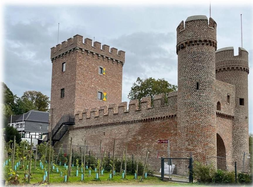
*Das Weiertor wurde im 2. Weltkrieg bis auf den Nordturm zerstört. Nach dem Krieg wurde der zweite Rundturm wieder aufgebaut. Das Haupttor wurde erst 2024 wieder aufgebaut.*
